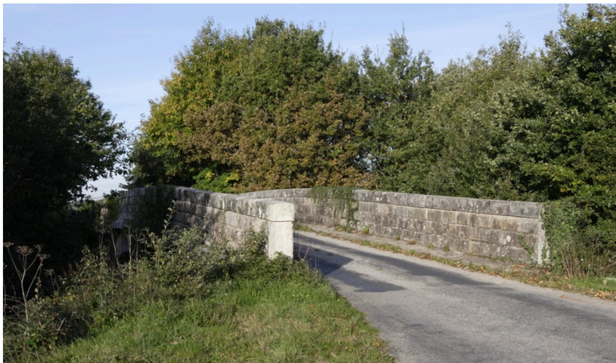
Partie supérieure du pont-route.
