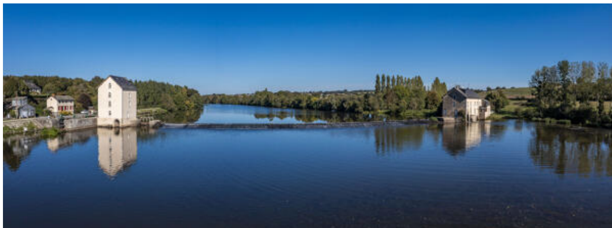
Le barrage et l'écluse de Neuville.
