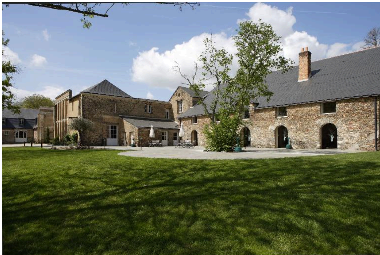
Bâtiment est, façade sud.
