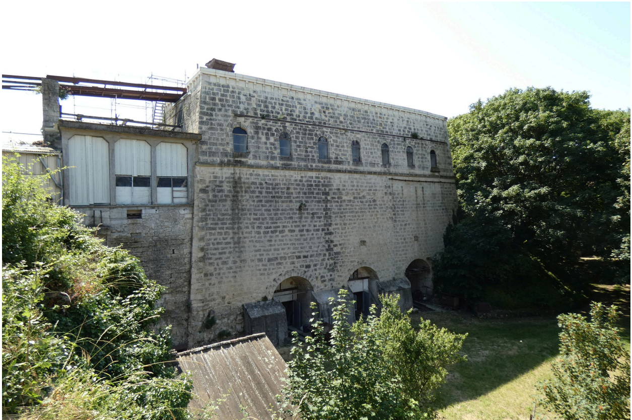
Le bâtiment des fours à chaux vu depuis le nord.
