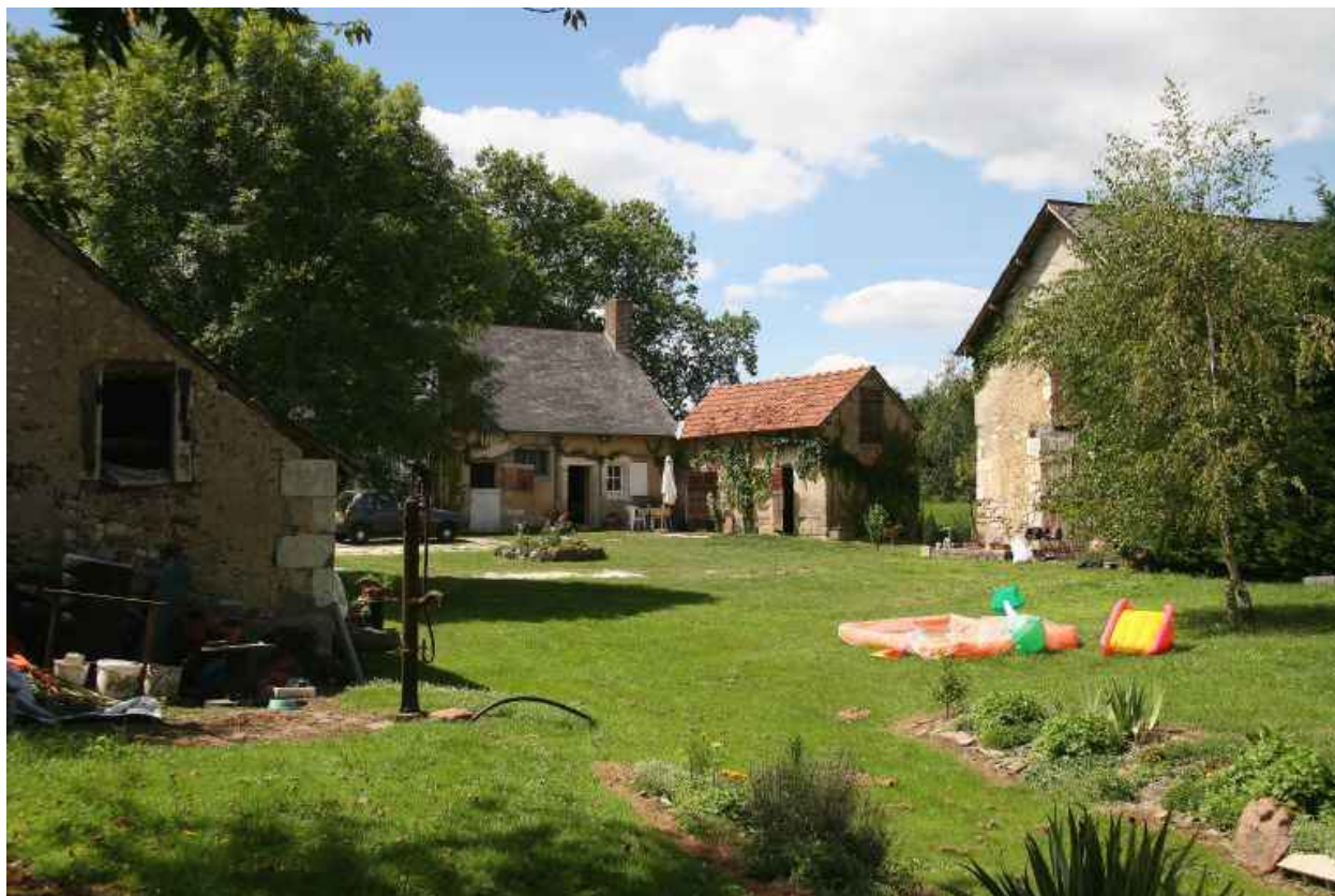
Vue d'ensemble depuis les caves.
