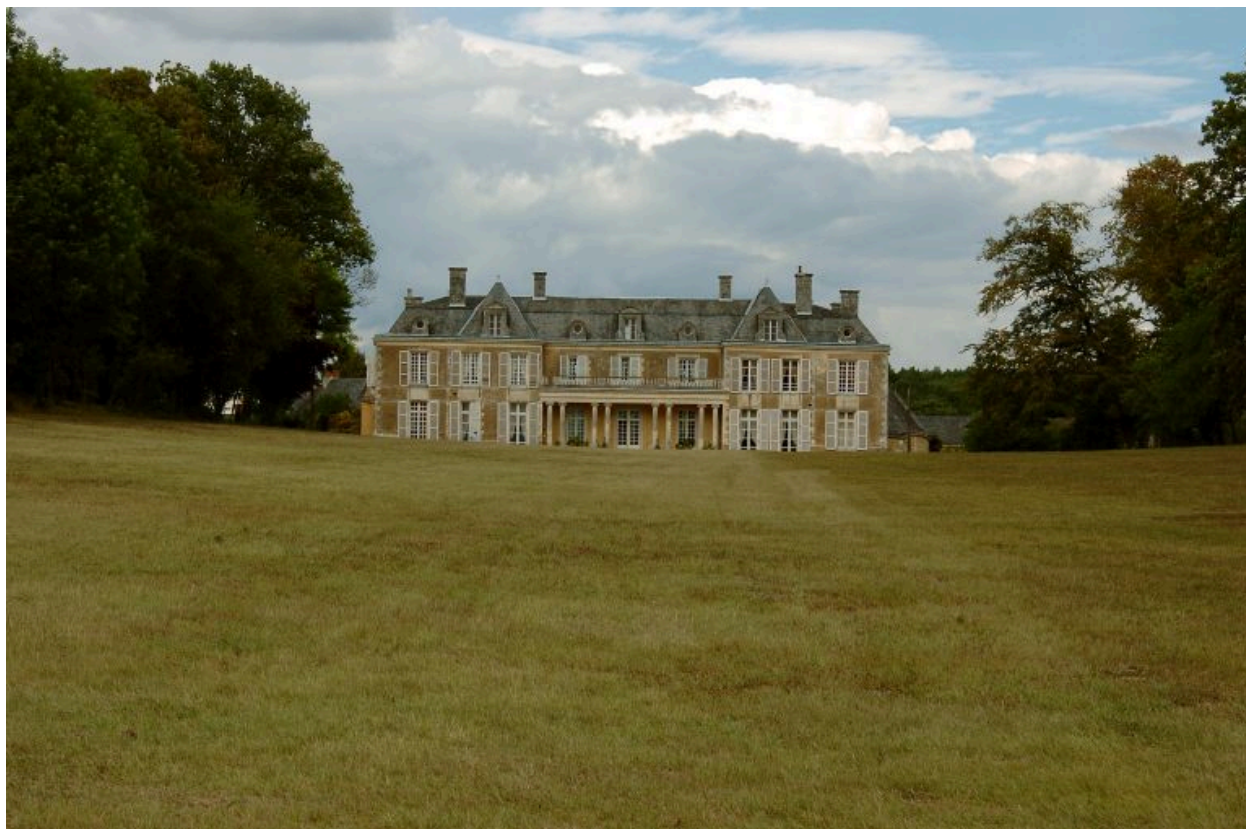
Façade sur le parc vue depuis la pelouse.
