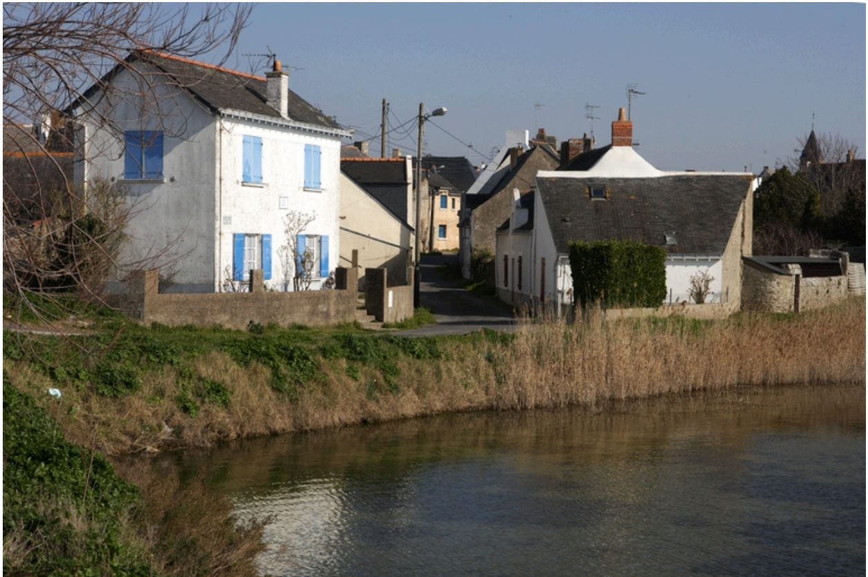
Vue de la rue des Carmes depuis le sud-ouest.
