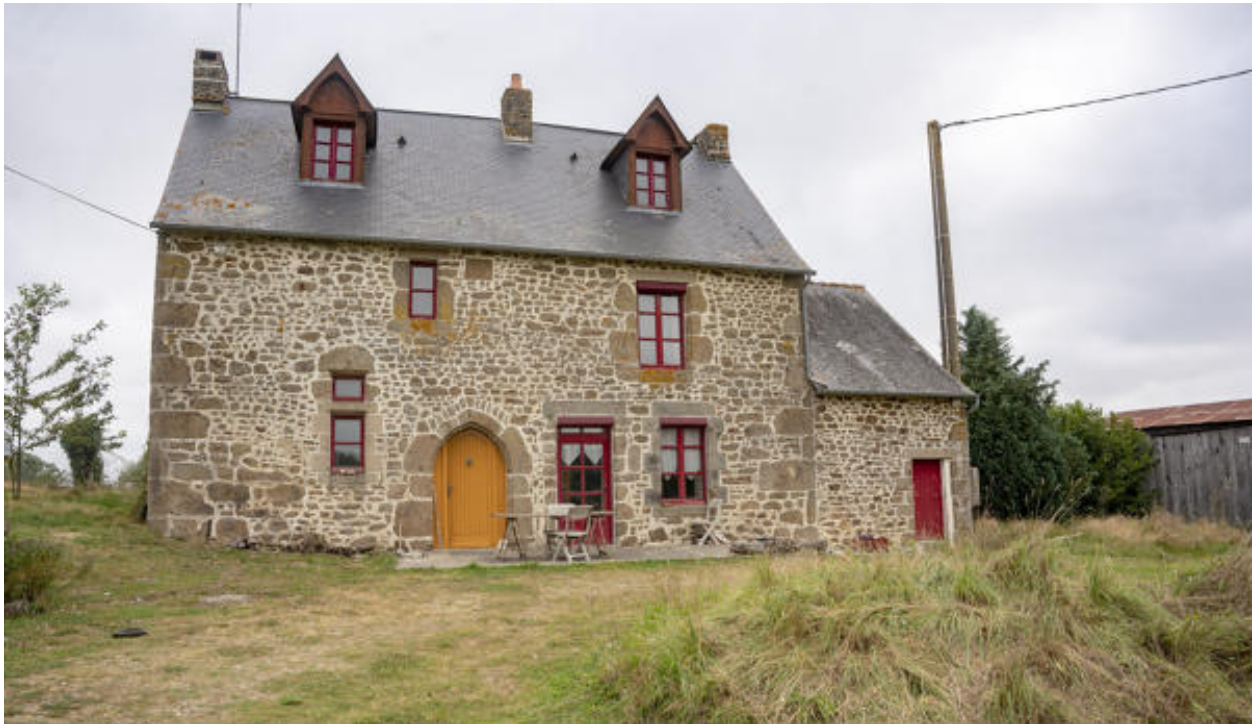
La façade antérieure de la maison.
