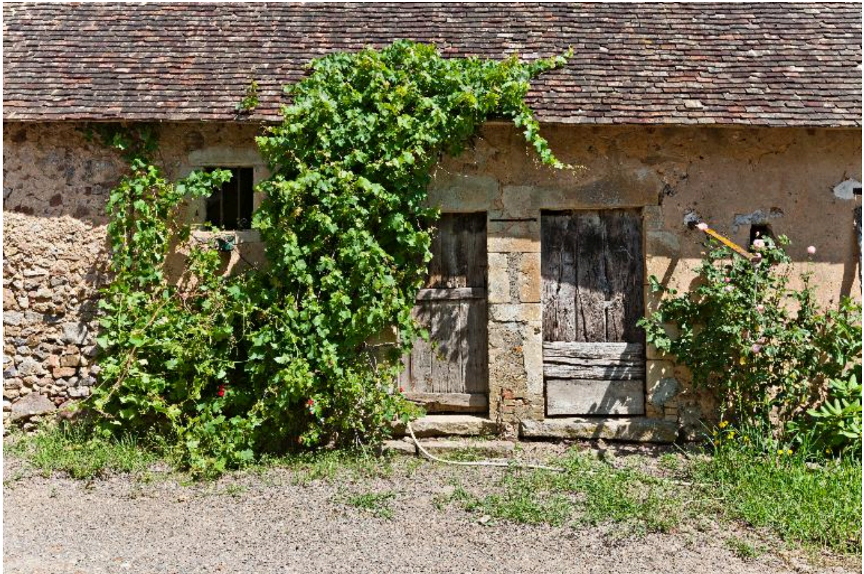
Elévation antérieure du logement.
