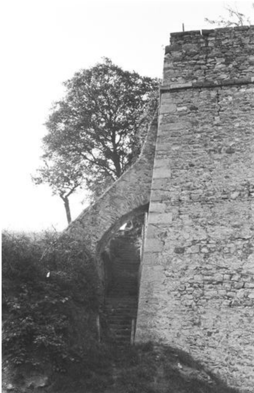
Fours à chaux : façade sud avec escalier et arcs boutants.
