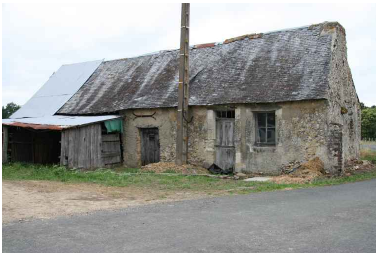
Vue de volume de la maison.
