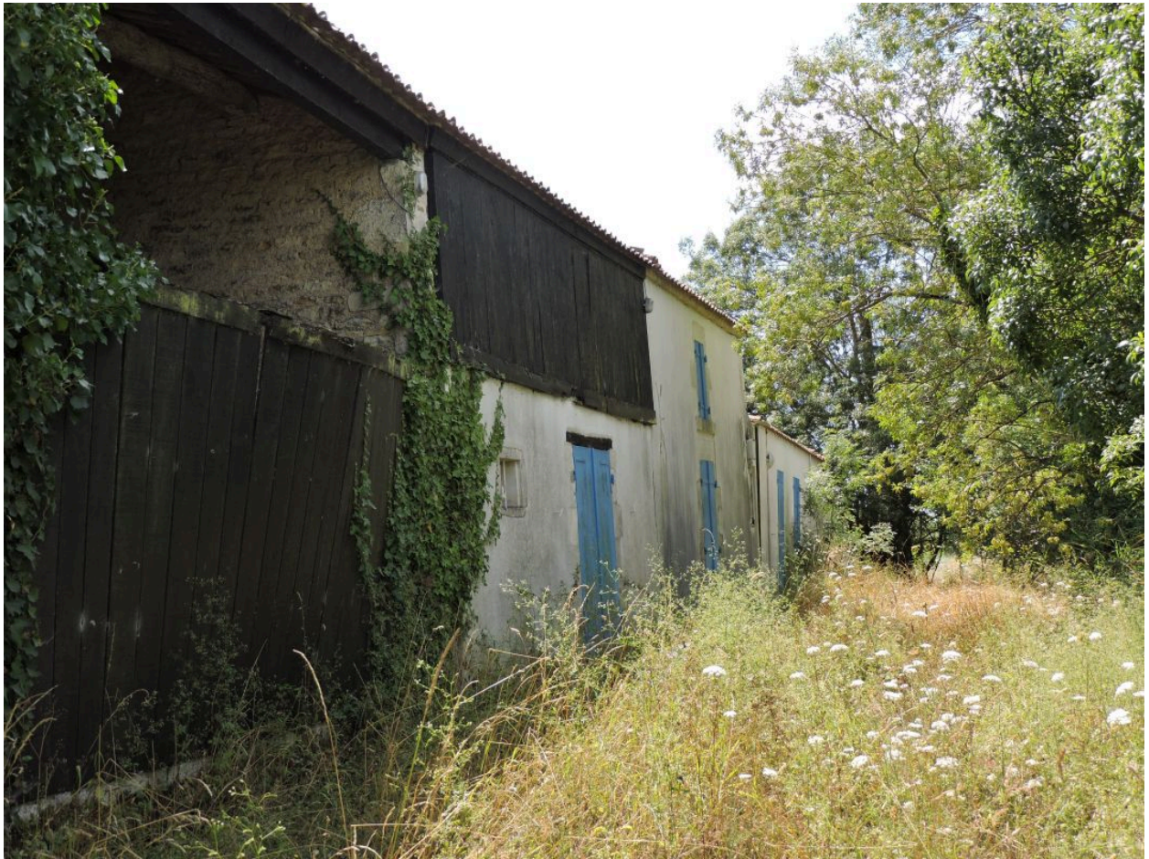
L'ancienne ferme vue depuis le nord-est : hangar, étable avec fenil au-dessus, logis.
