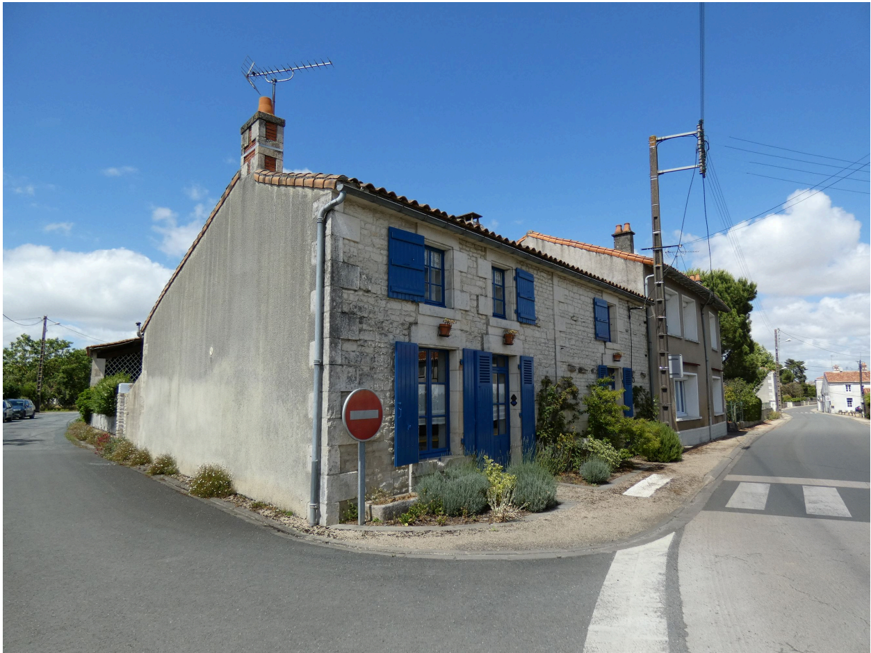
Le logis vu depuis le sud.
