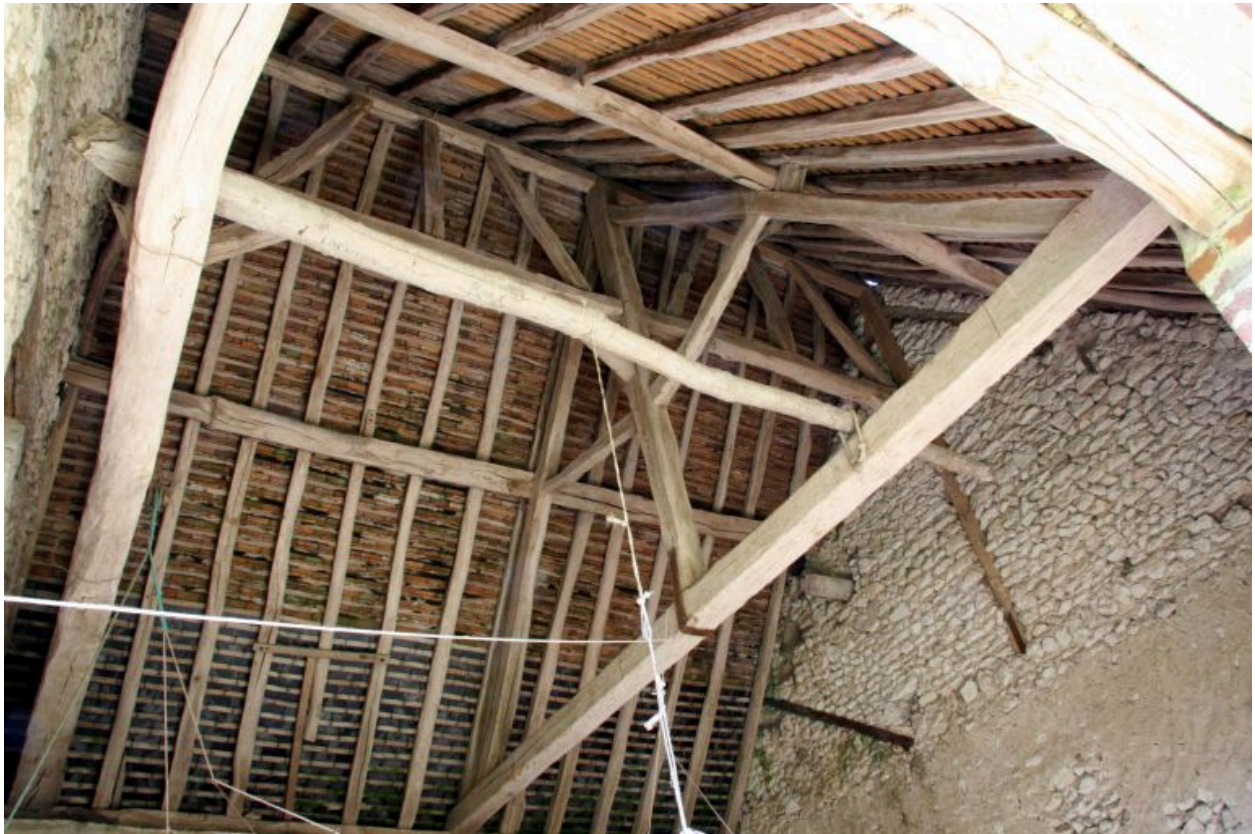
La grange, détail : la charpente avec sous-faîtage.
