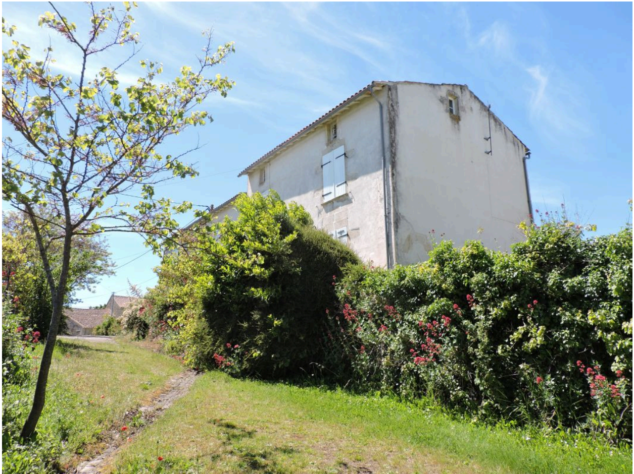
La maison vue depuis l'est.
