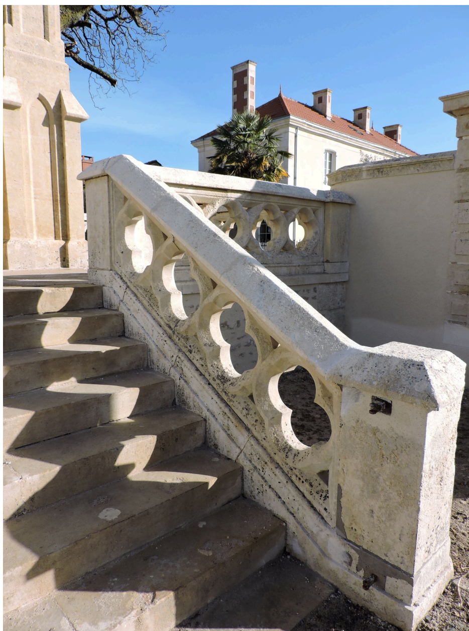
Le garde-corps de l'escalier.
