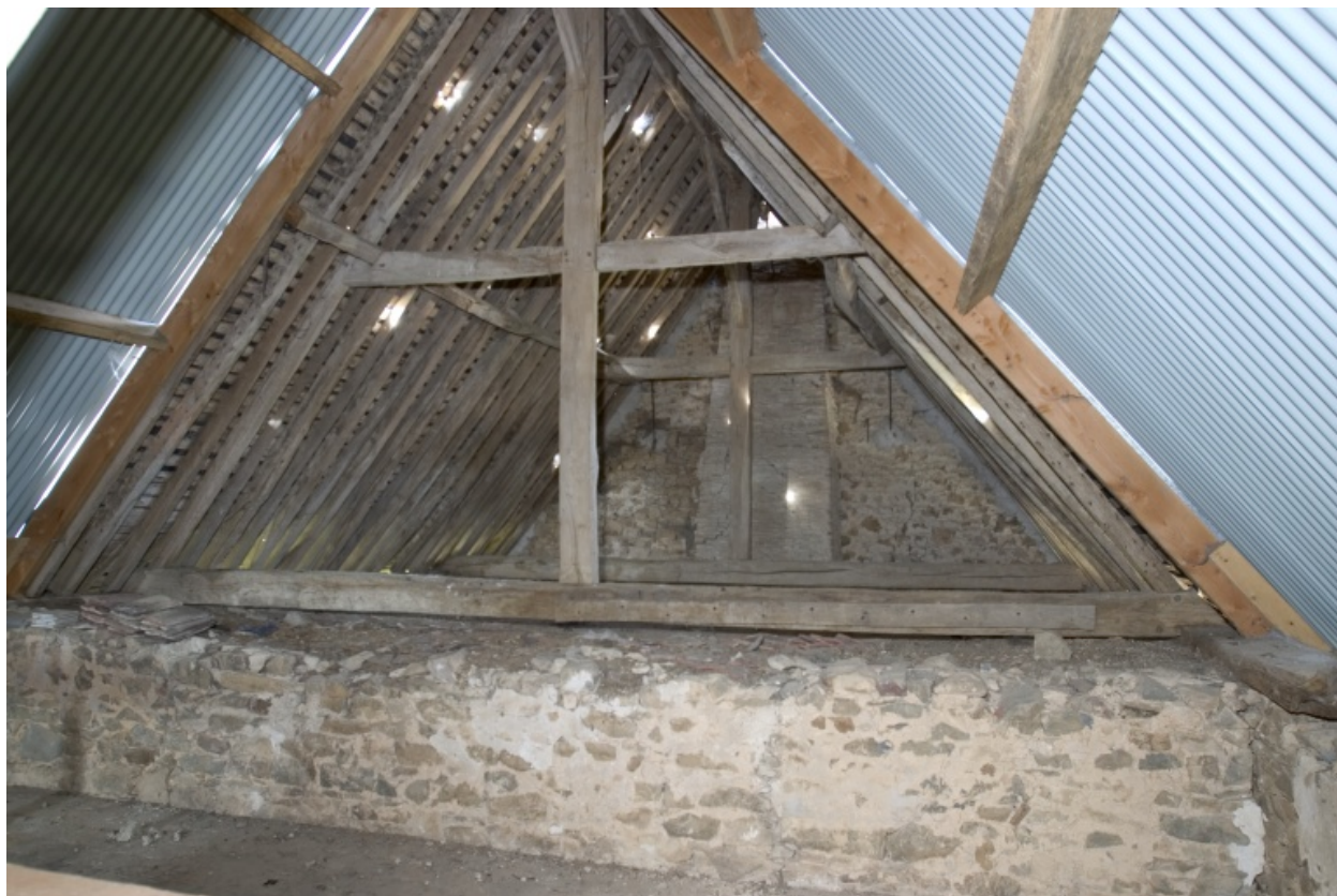
La charpente du logis : partie nord-ouest.
