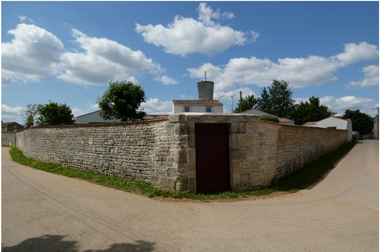
Mur de clôture en moellons à l'angle de la rue des Tombeaux et de la rue de la Crie.
