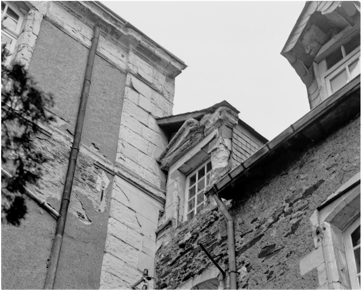
Bâtiment de l'infirmerie, façade sud : lucarne ouest.
