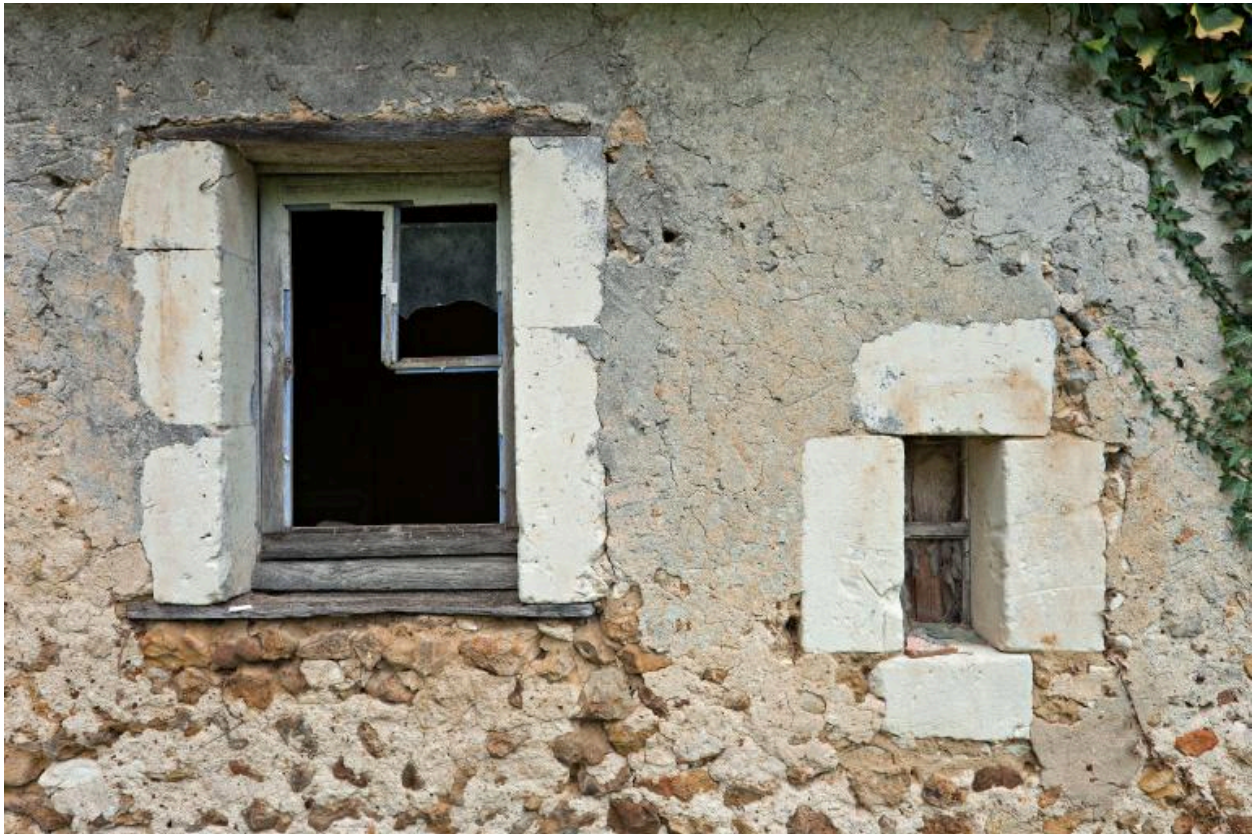
Façade antérieure : baies de la chambre froide.
