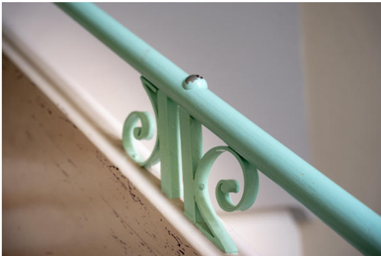
Vue d'un détail de ferronnerie de la rampe de l'escalier intérieur.
