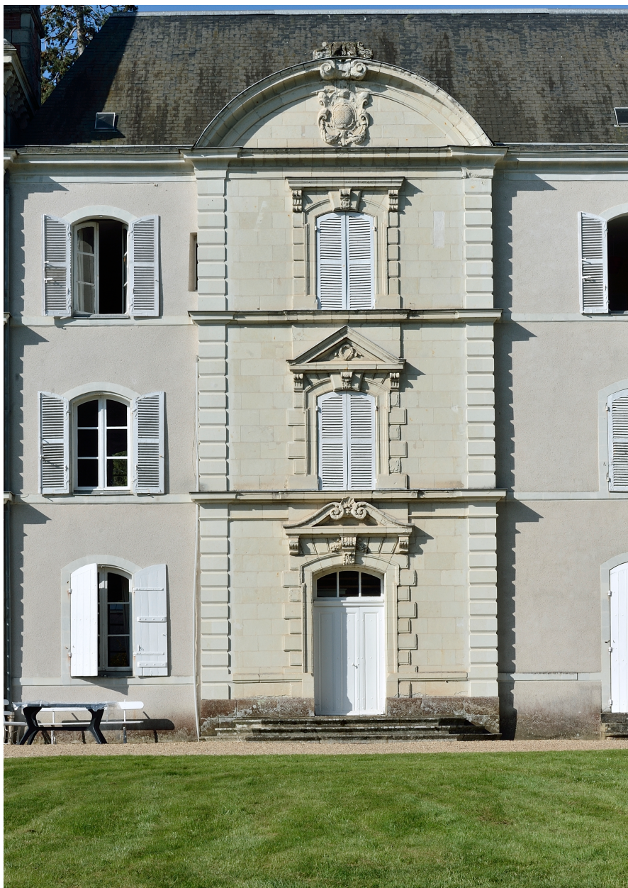
Façade est. Détail de la travée centrale.
