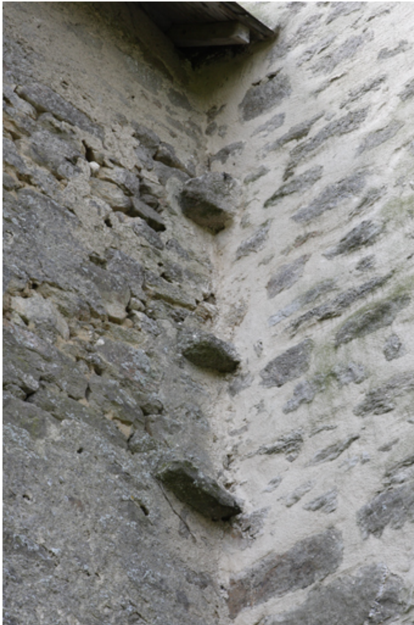
Logis. Façade nord. Détail des pierres d'attente à l'angle du mur gouttereau et de la tour d'escalier.
