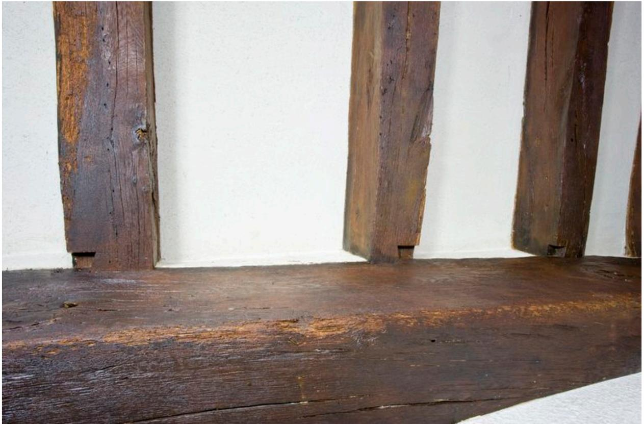
2e étage, pièce antérieure : détail d'assemblage poutre de sous-faîtage et solives qui se sont partiellement désolidarisées, mettant à jour le système d'encoches.
