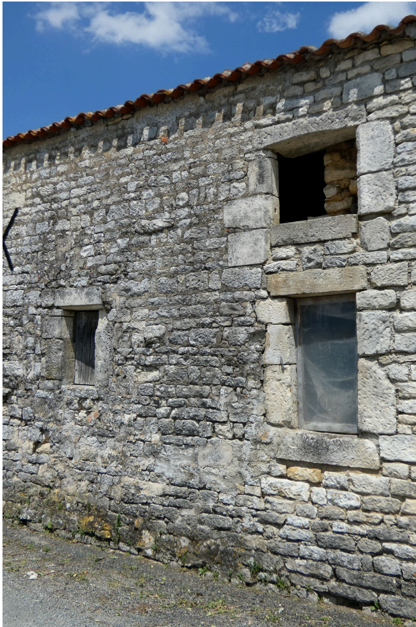
Ouvertures de la dépendance, ancienne chapelle.
