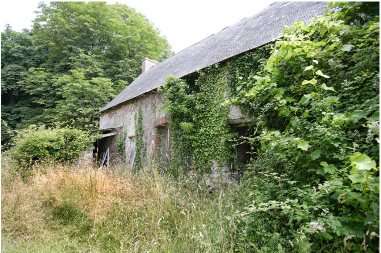
Communs. Façade est.
