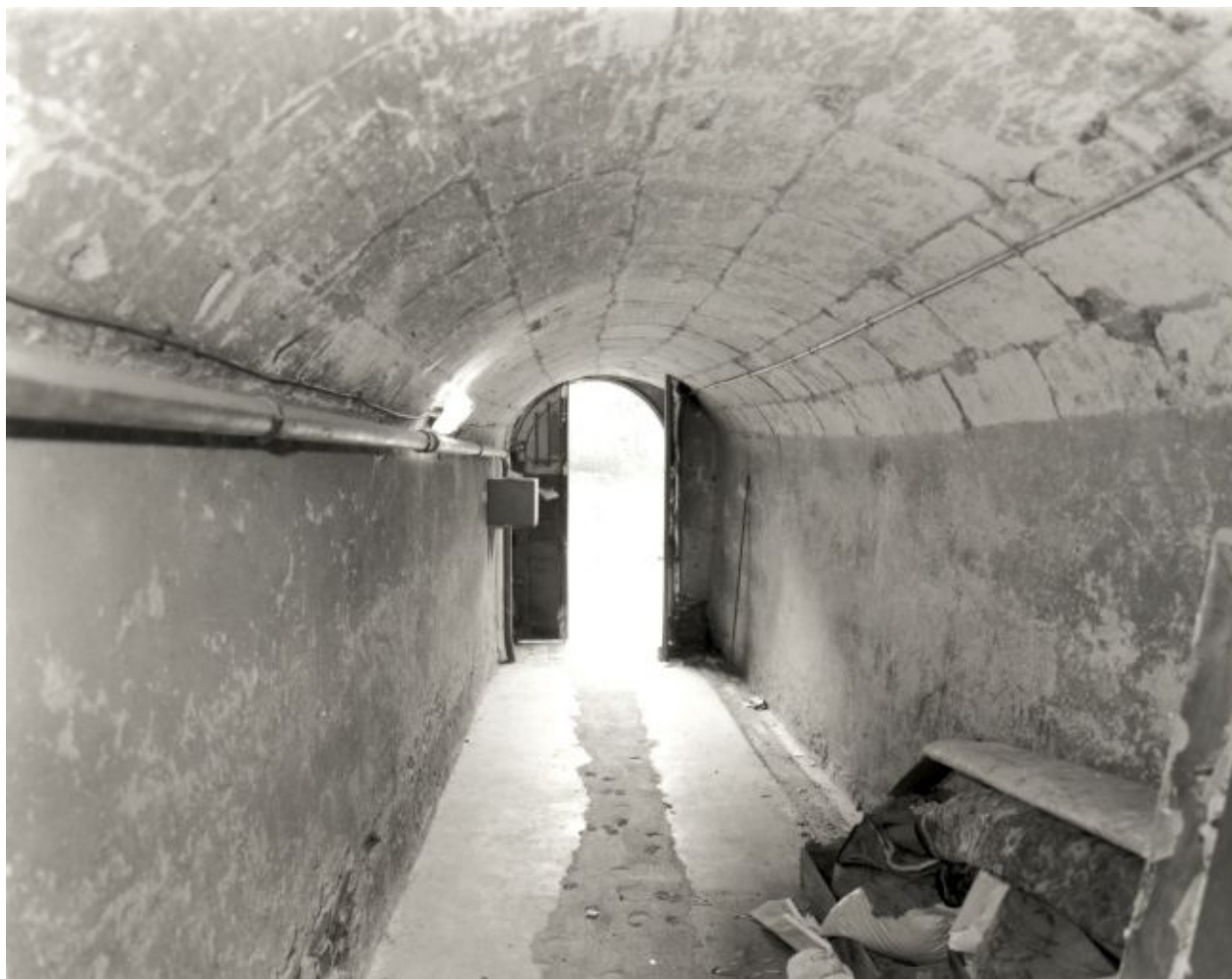
Corps de logis gauche : couloir de liaison entre la rue Saint-Georges (au fond) et une petite cour postérieure.
