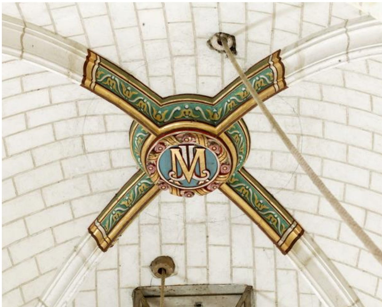
Nef, première travée, baptistère : clé de voûte avec les monogrammes du Christ et de la Vierge.
