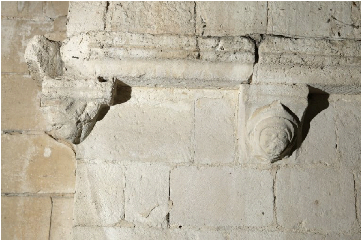
Chapelle orientée du bras sud du transept : modillons romans du côté extérieur du mur est, pris des combles de la sacristie.
