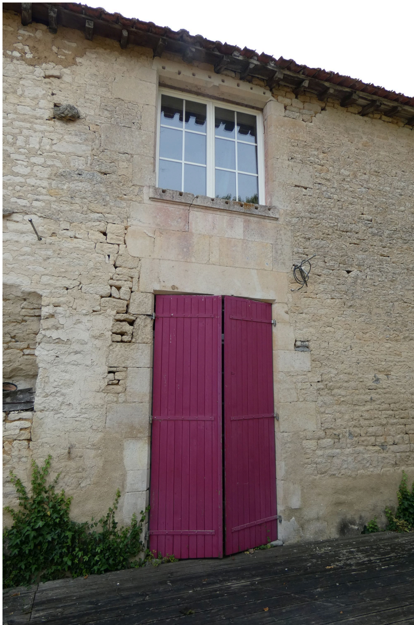
Travée d'ouvertures sur la façade nord du logis.
