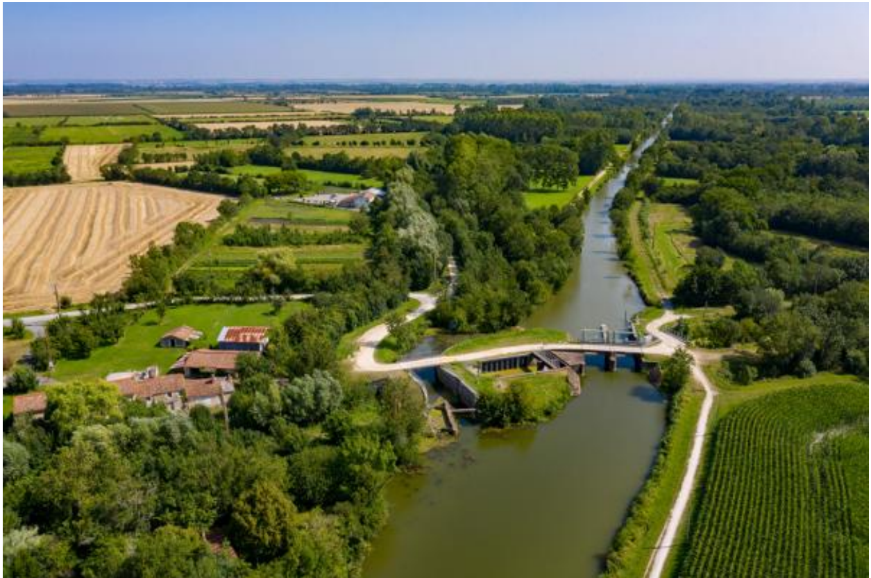
Vue aérienne de l'aqueduc depuis le sud.
