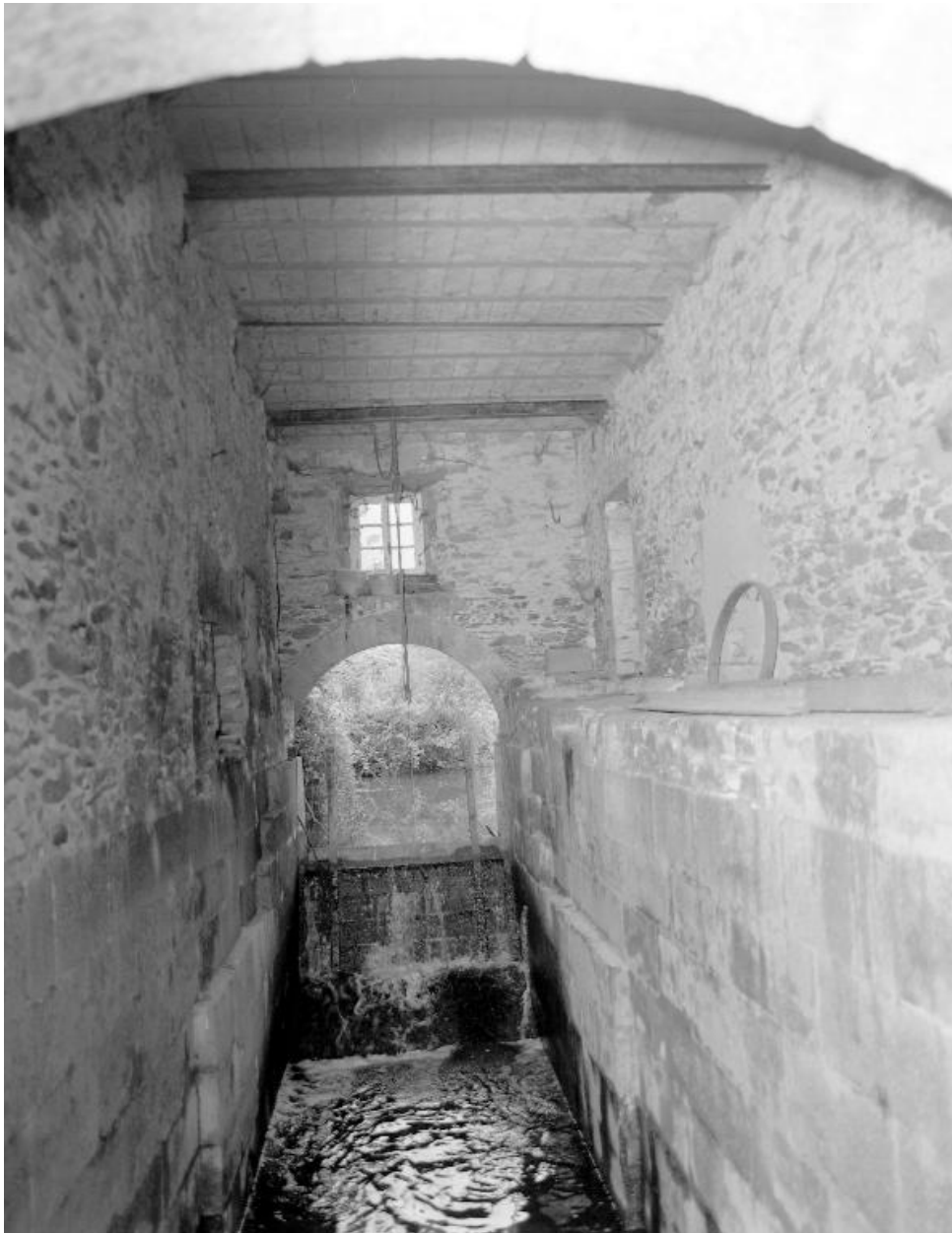
Vue intérieure du coursier depuis l'aval.
