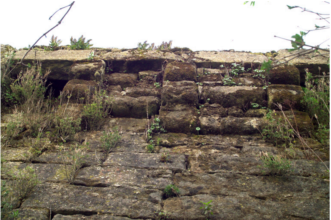
Détail des consoles portant encorbellement sur l'enceinte voisine.
