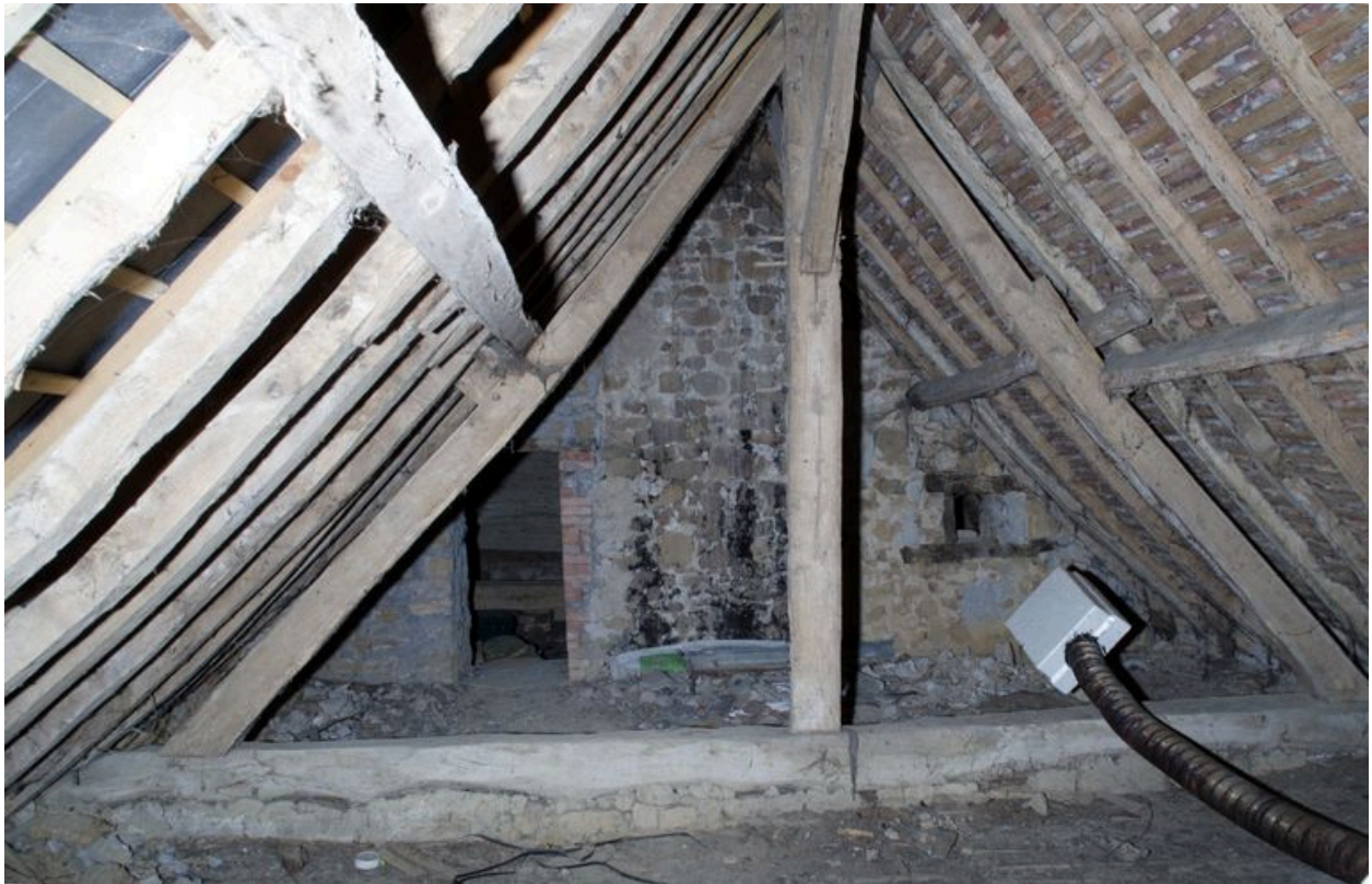
Ferme de charpente d'un des anciens logis ouest (logis droit) de l'alignement.
