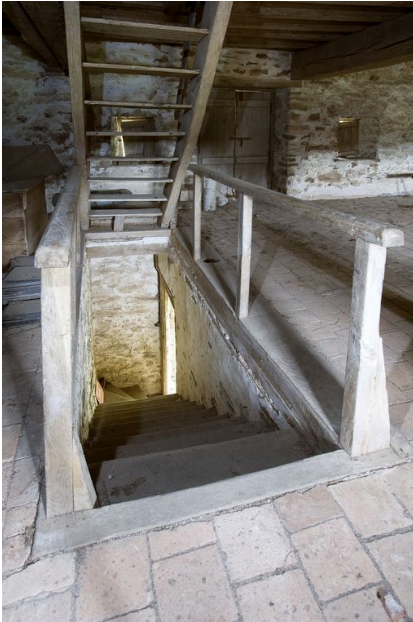
Ecurie-grange : escalier d'accès au premier étage.
