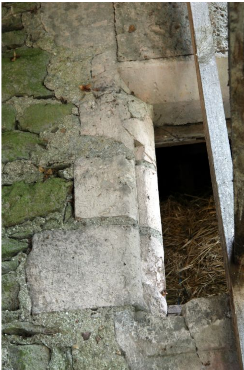
Face ouest, 2e croisée, détail : traverse rehaussée.
