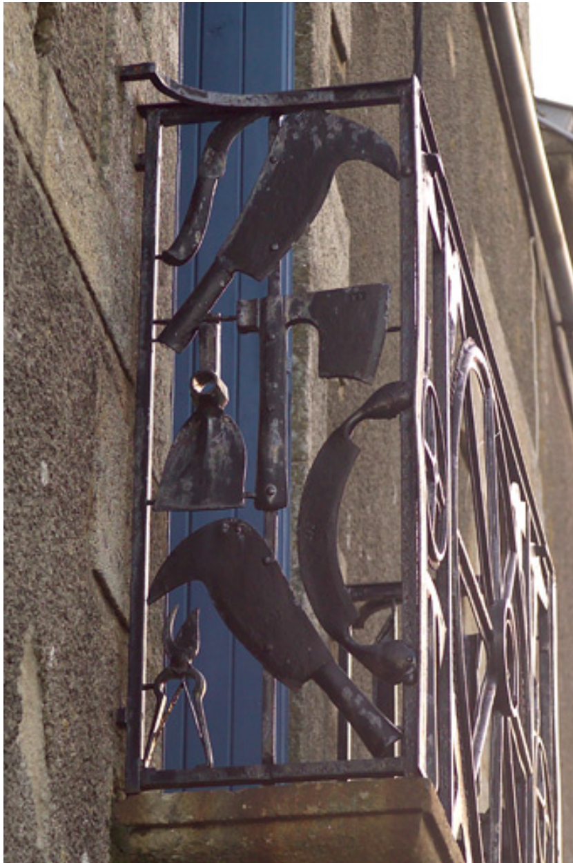
Garde-corps du premier étage, face ouest.
