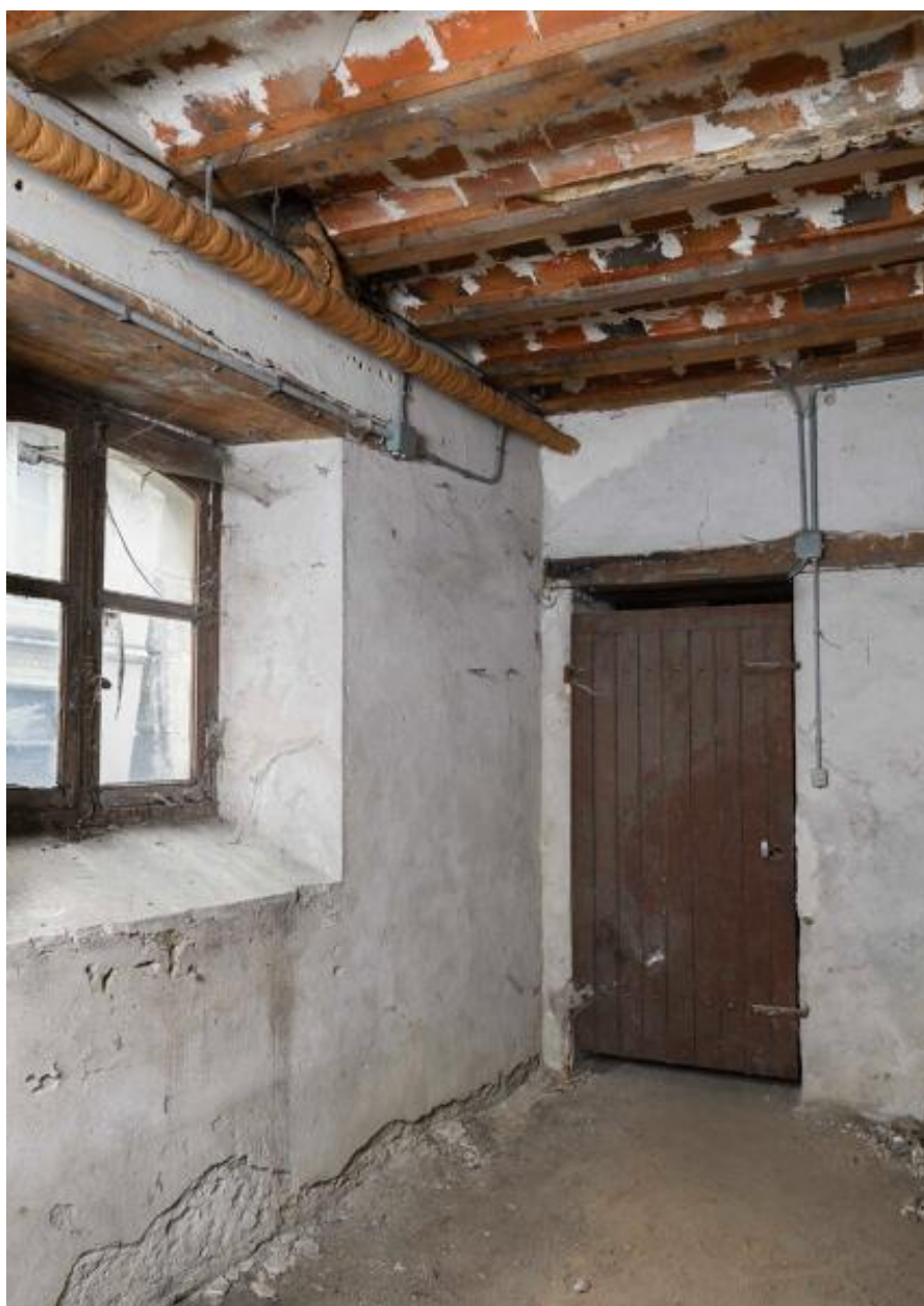
Intérieur, étage de soubassement avec plancher à voûtain, école de filles, Montjean-sur-Loire.
