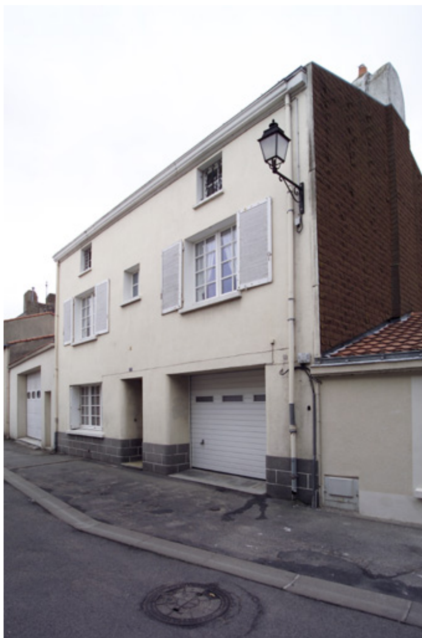
La maison n° 17 rue Saint-Gilles.
