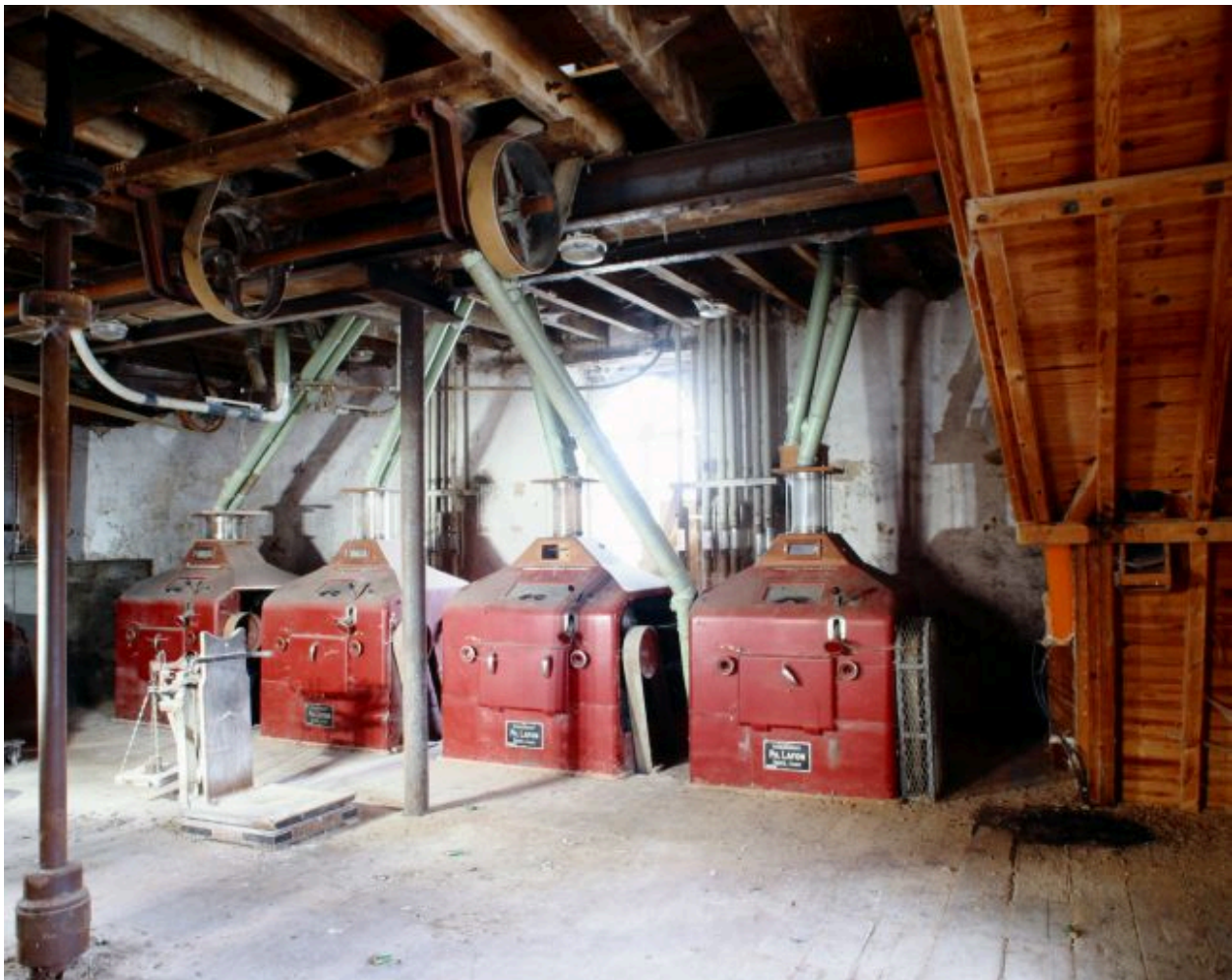
Premier étage, partie nord vue depuis le sud-est, en 2002 : les broyeurs à cylindres de la marque Ph. Lafon, installés en 1958.
