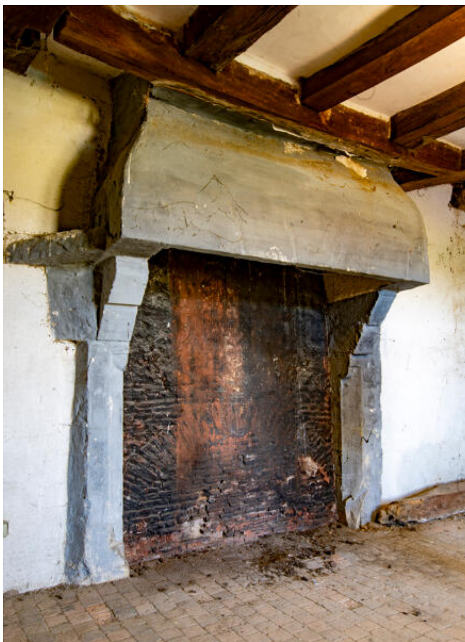
La cheminée de la pièce à l'étage.
