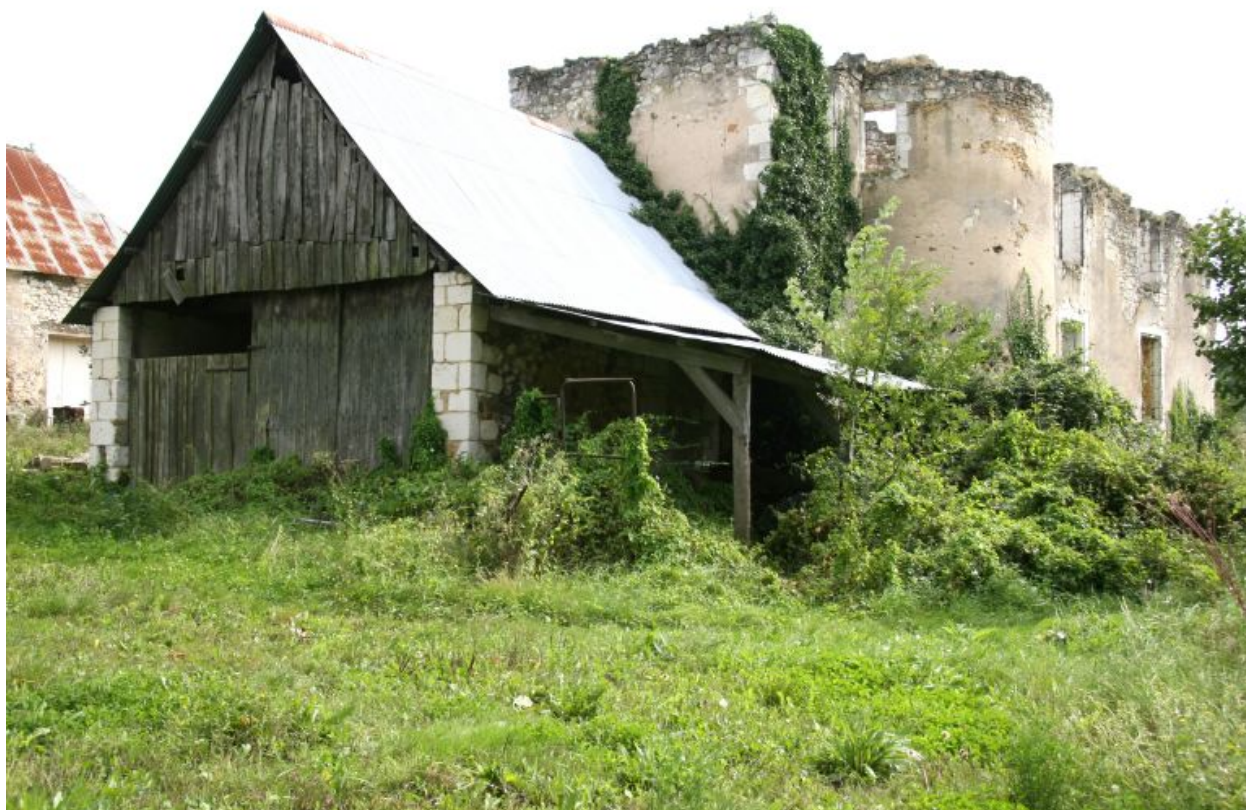
Pignon ouest : tour.
