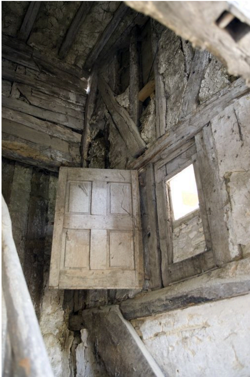
Fenêtre de la tour d'escalier.
