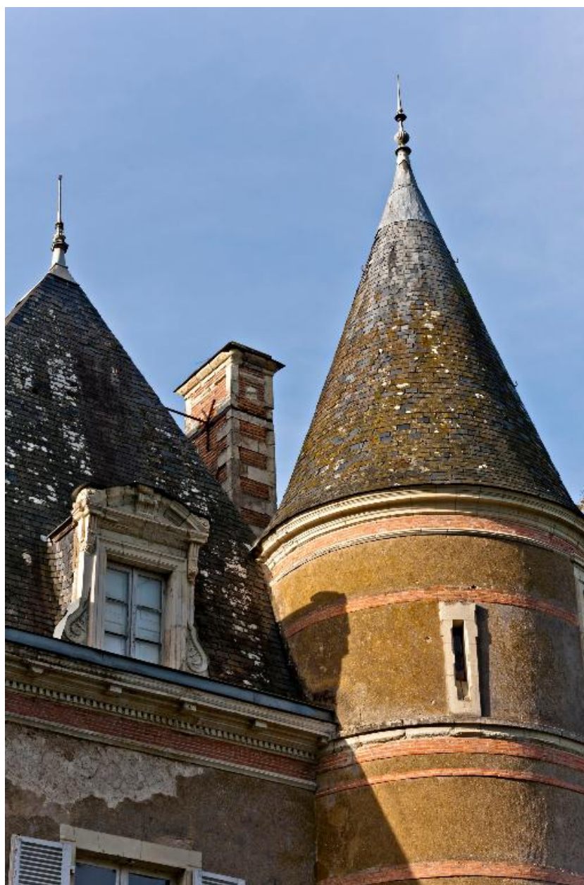
Vue de détail de l'élévation antérieure : parties supérieures du pavillon et de la tourelle nord-ouest.
