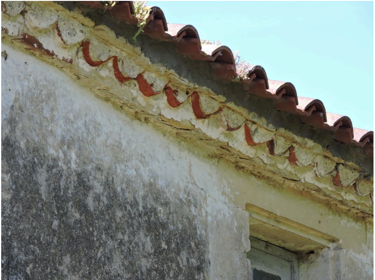
Détail de la génoise.
