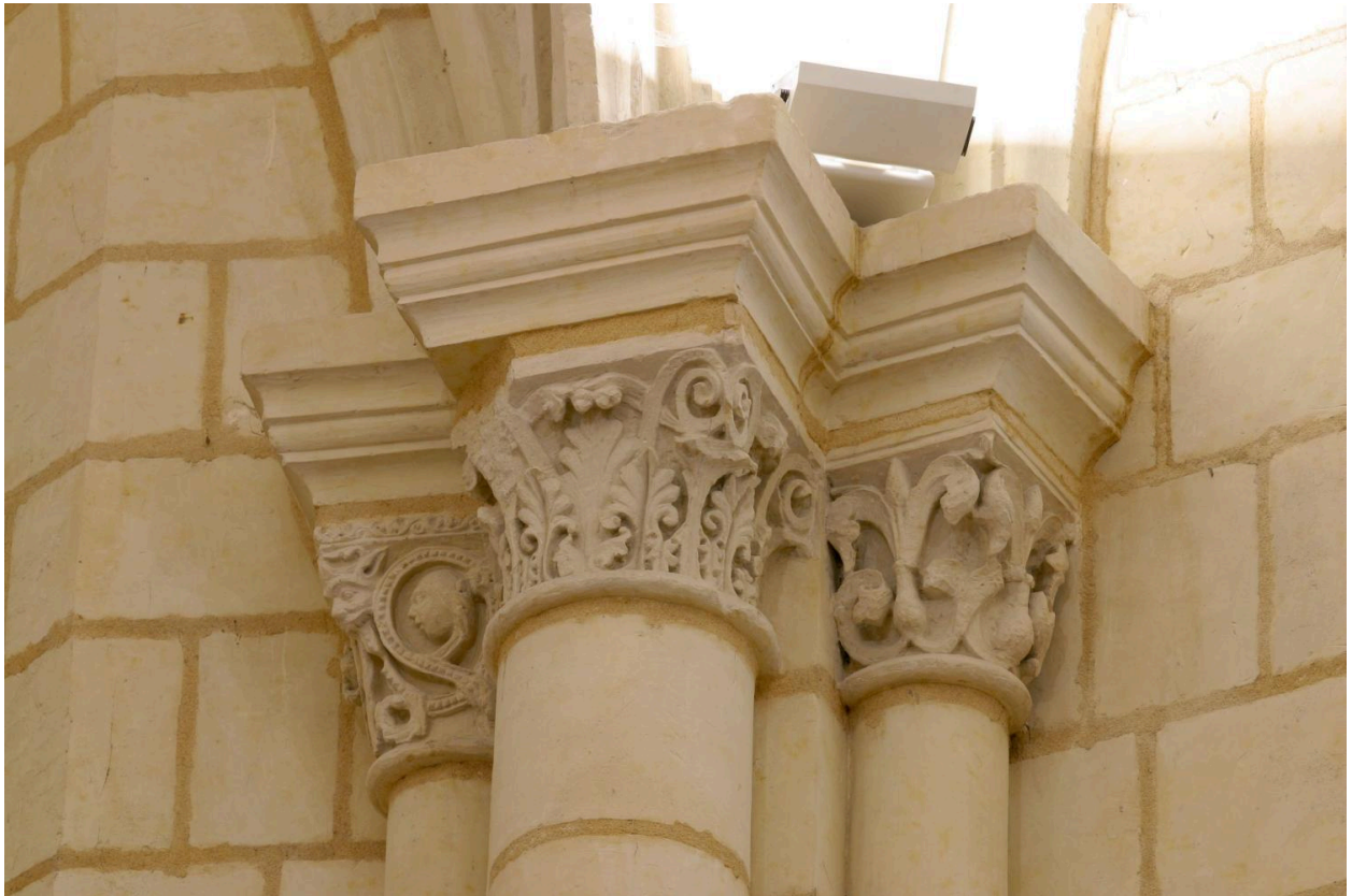
Chapelle Saint-Eloi. Abside : groupe de chapiteaux à feuillage à droite de la baie axiale : vue d'ensemble.
