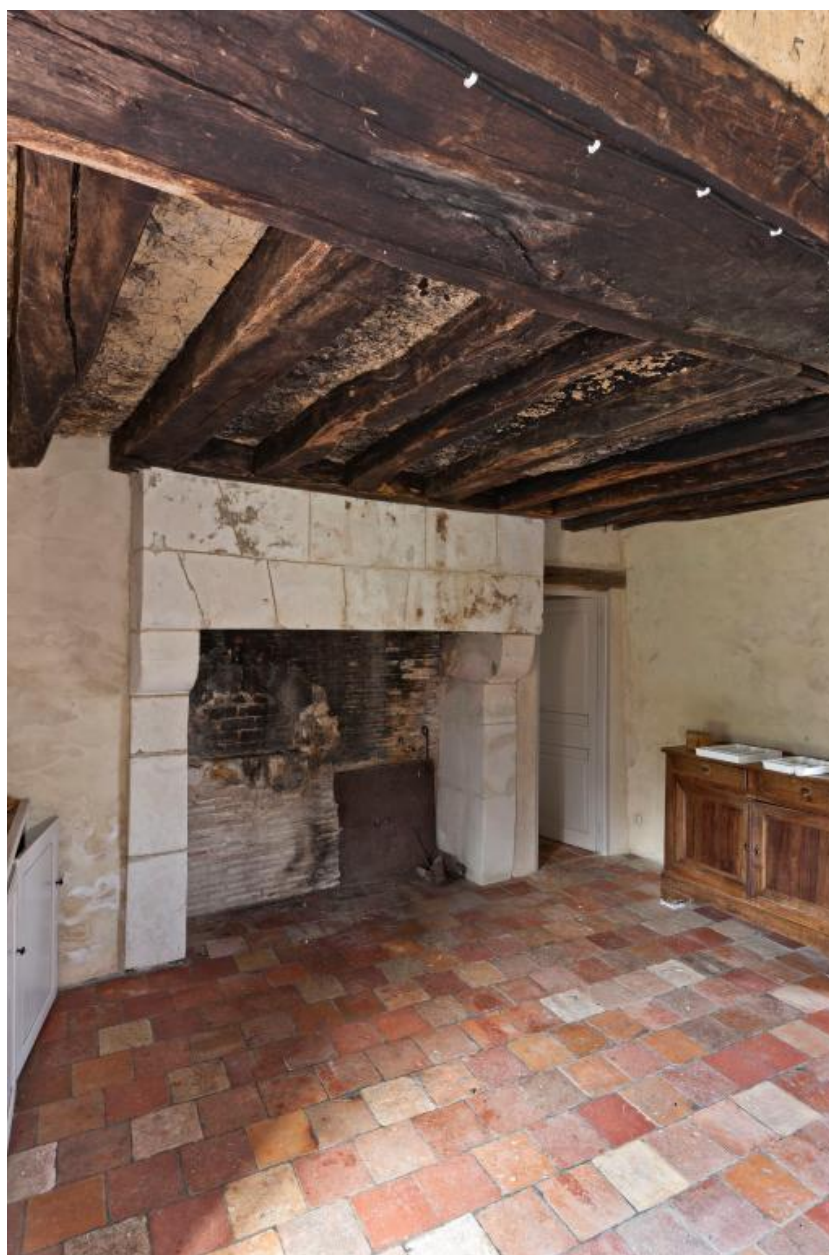
Dépendance 2, RdCh, pièce à feu : cheminée.
