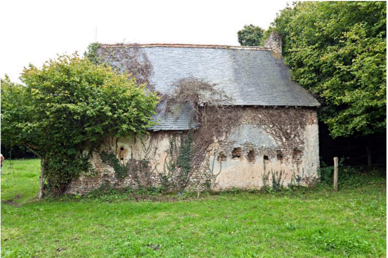
Façade postérieure aveugle.
