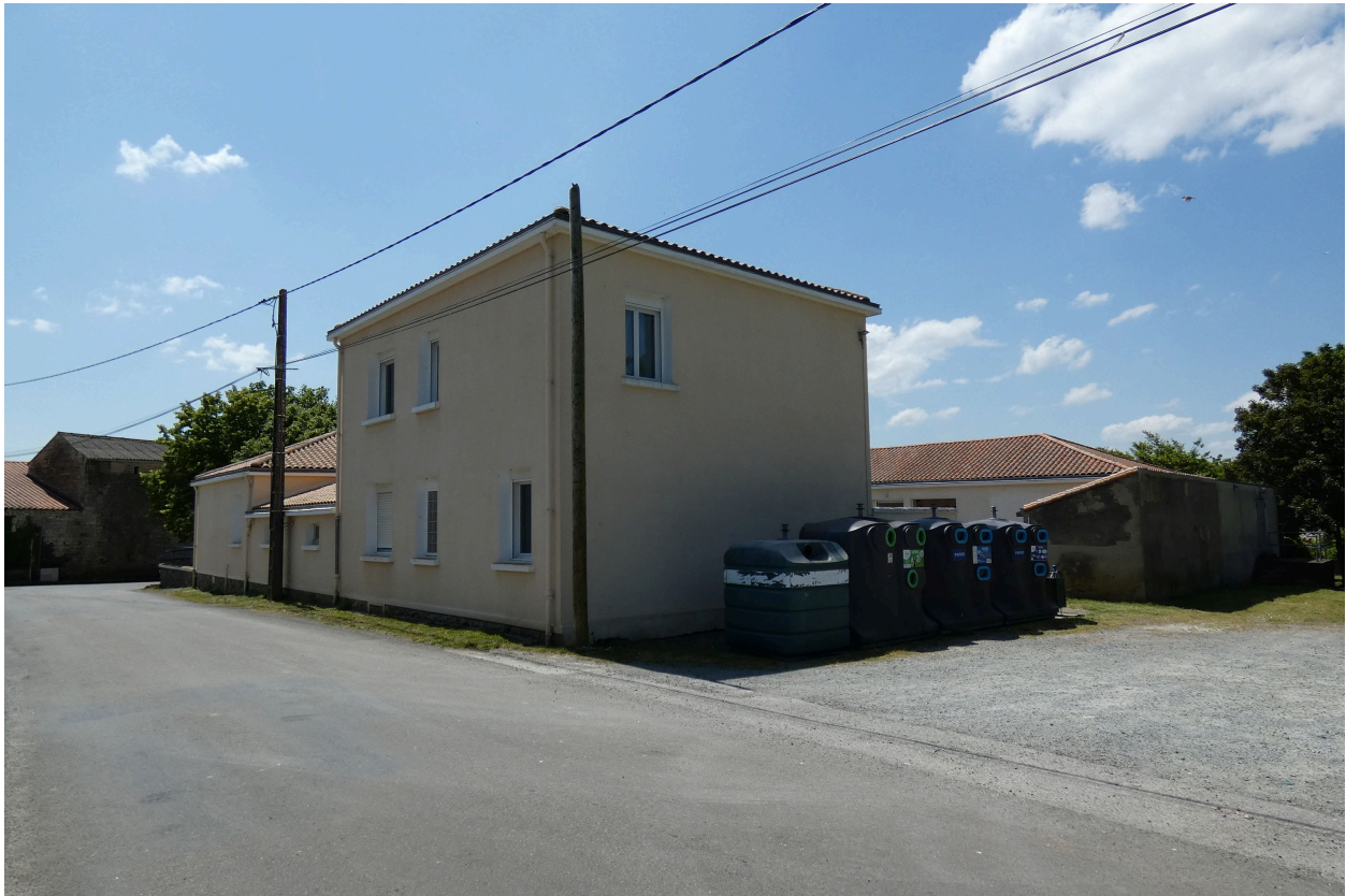
L'ancienne école vue depuis le nord-est.
