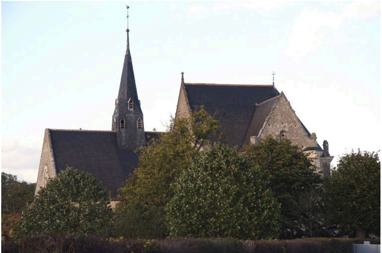
Vue de volume prise du sud.
